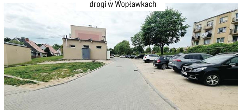
Przed i po przebudowie drogi w Woptawkach
