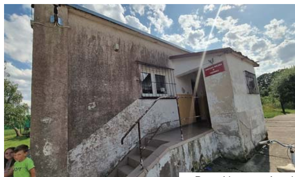
Przed i po modernizacji świetlicy w Mażanach
