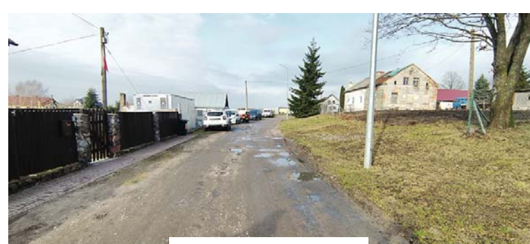
Przed i po przebudowie drogi w Nowej Różance
